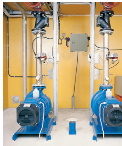
На рисунке изображена вертикальная установка насосов FR и установочное устройство. Насосы FR также могут быть установлены вертикально.
